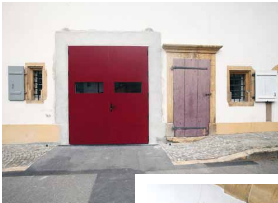
La nouvelle ouverture latérale est juxtaposée à la petite porte historique. Elle permet le passage de transpalettes.
